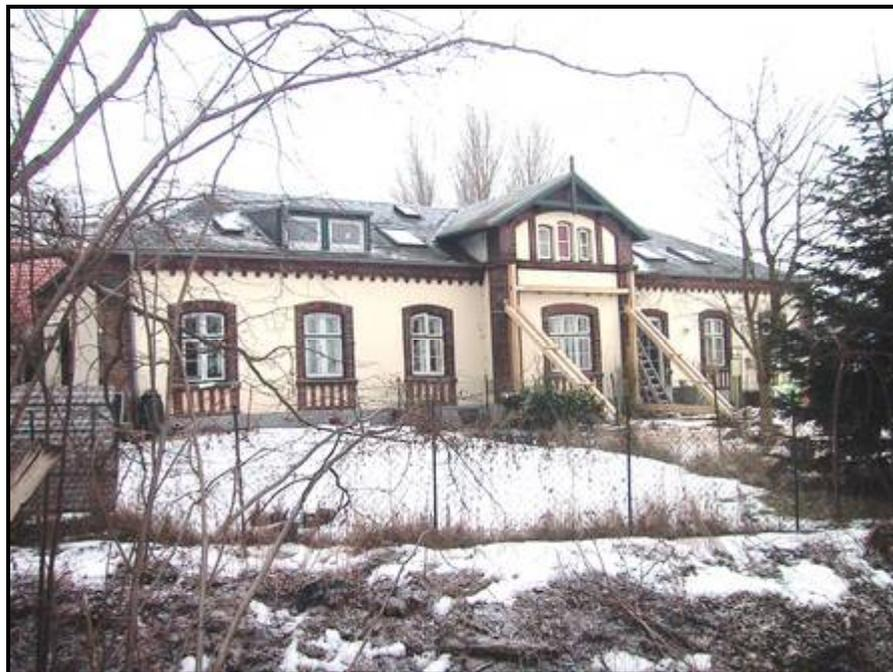
*Der Mittelrisalit musste bereits konstruktiv gesichert werden*
