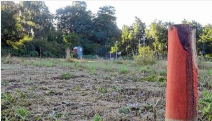
Die Pflöcke, die den Grundriss der neuen Kita abgrenzen, sind bereits eingeschlagen. Foto: Bunk
